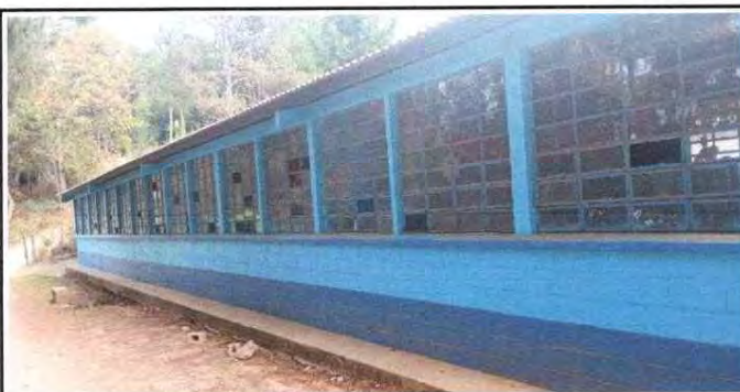
Foto 5: Cambio de vidrios
