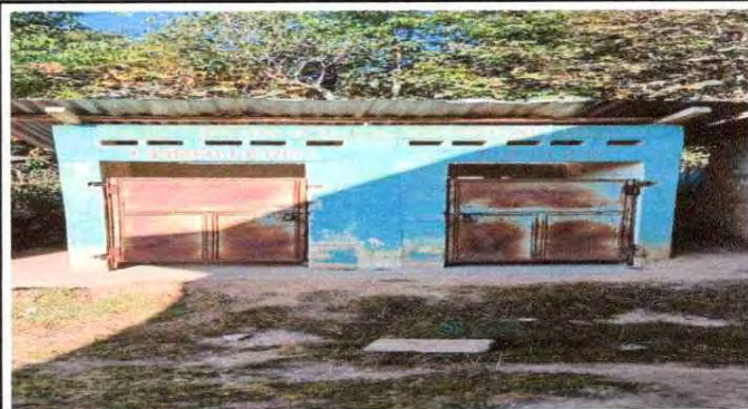
Foto 2: Sustrucción de puertas en baños
