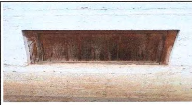
Foto 4: Sustrucción de ventana de madera por metal
