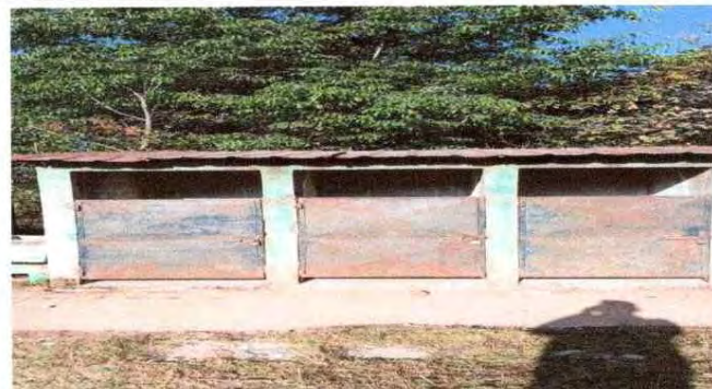
Foto 2: Mantenimiento a estructura en puertas de servicios sanitarios
