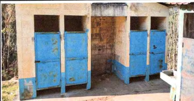
Foto 1: Pintura en muros exteriores e interiores
