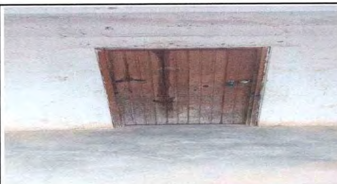
Foto 3: Sustrucción de puerta en cocina
